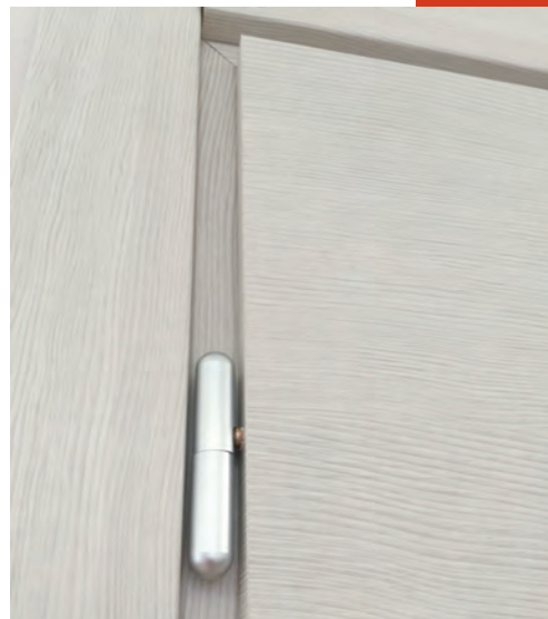
Cerniere anuba con regolazione micrometrica
